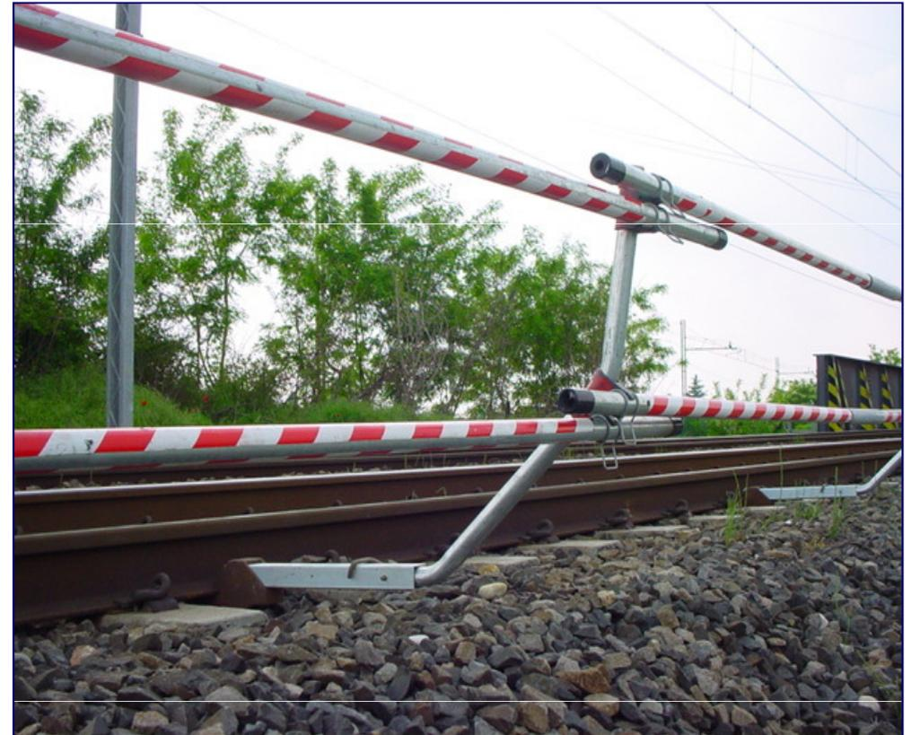
Il loro uso è previsto per cantieri fissi e di durata medio/lunga (Cantieri fissi operanti in area adiacente al binario in esercizio, come per esempio cantieri di opere civili, quali rifacimento marciapiedi, lavori di contenimento, etc). Non compatibili con i cantieri mobili dell'armamento (rinnovo binario).
